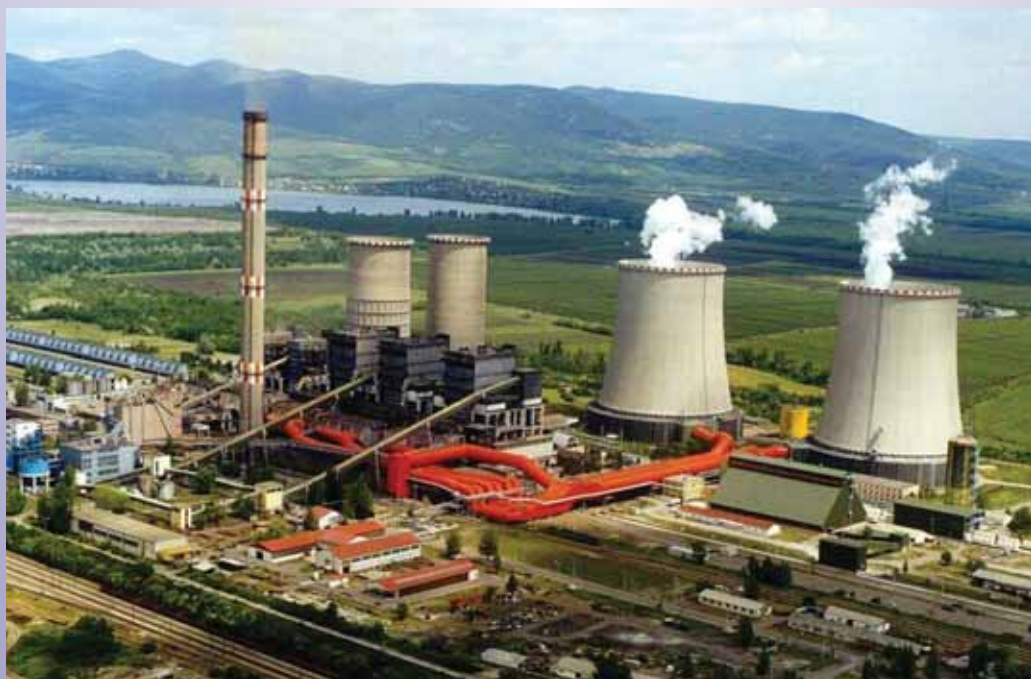
A lignittüzelésű Mátrai Erőmű hazai főberendezésekkel és Heller-rendszerű léghőköndenzátorokkal
